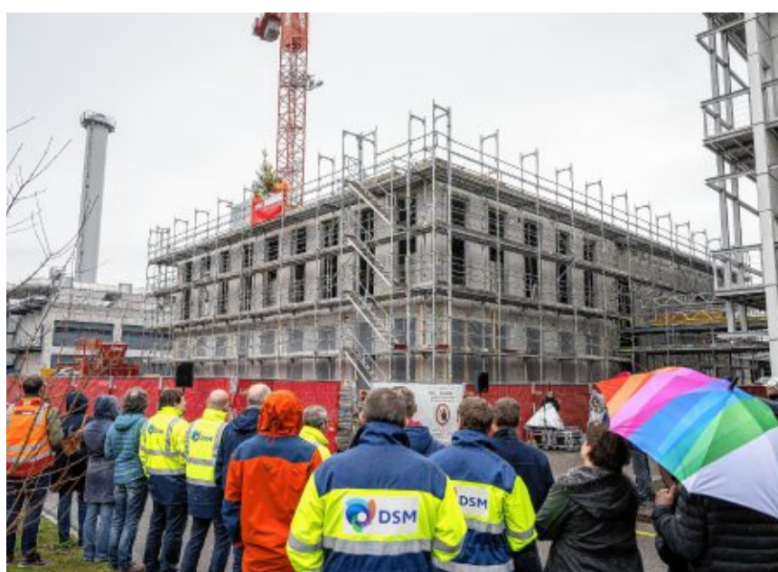
Richtfest wird beim erst im September begonnenen Entwicklungsgebäude der DSM auf dem Sisslerfeld gefeiert. BILD: SEVERIN LEBER
